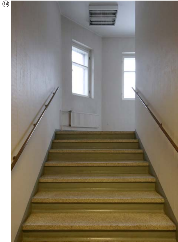
↑ Mosaiikkibetonisten porrasaskelmien alla on harmaaksi maalattu betonirakenne.
