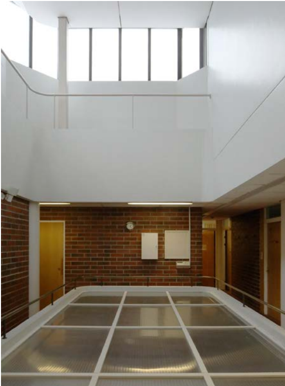
↑ Kolmannen kerroksen aulassa valokuilun yläosa on säilynyt avoimena. Yhteys alapuolisiin kerroksiin on suljettu lasikatoon.
