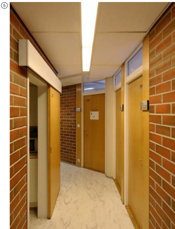
↑ Toimistokäytävät ovat kapeita ja kaartuvia rakennuksen pohjamuodon mukaisesti.
