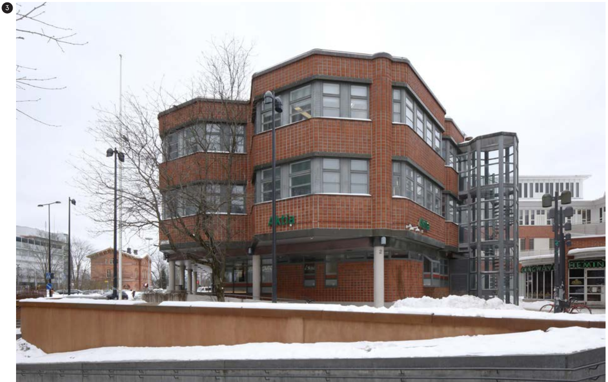
↑ Koillisen puoleisessa, Asematien suuntaan avautuvassa julkisivussa korostuvat kaksi suurta kulmiltaan viistettyä erkkerimuotoa. Julkisivu on samassa linjassa Asematien muiden rakennusten kanssa.
