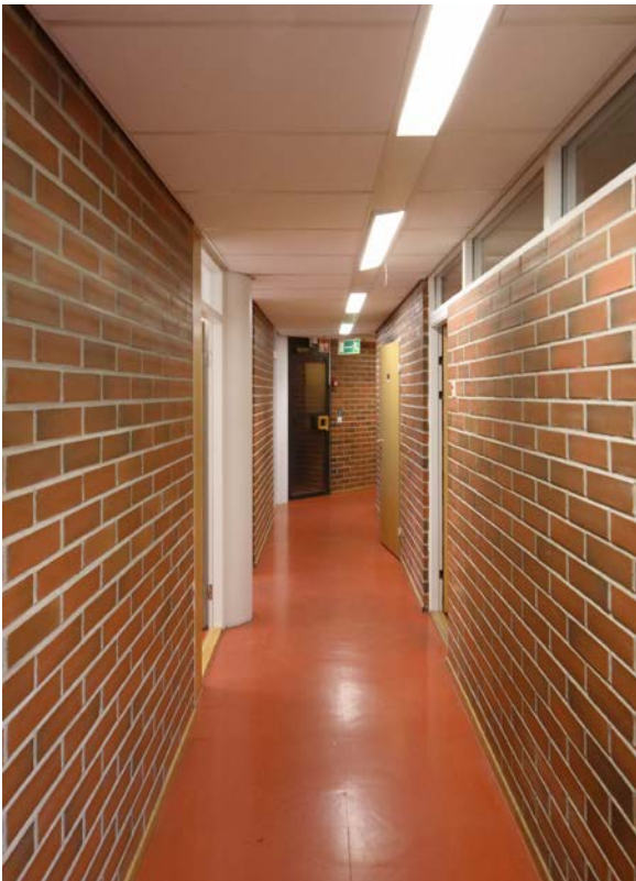
↑ Kolmannen kerroksen käytävillä on säilynyt oletettavasti alkuperäinen punainen muovilattia.
