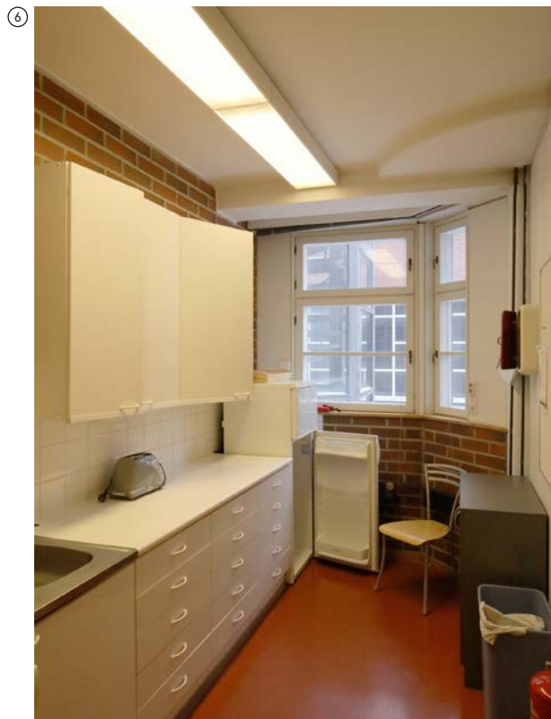
↑ Pienkeittiössä on säilynyt luultavasti alkuperäinen punainen muovi-laattalattia. Keittiökalusteet ovat myöhemmästä muutosvaiheesta.
