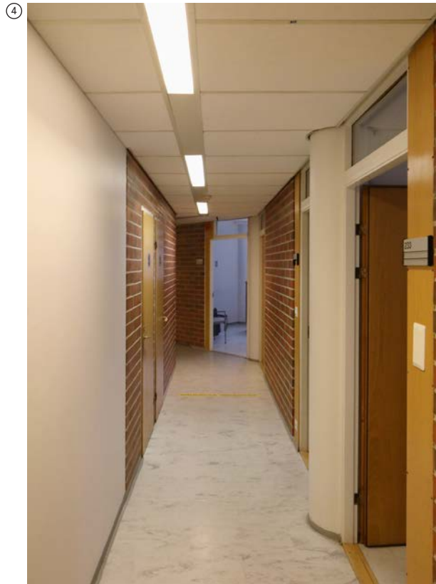
↑ Seinien kohdille asettuvat pyöristetyt betonipilarit korostuvat seinämuodossa.
