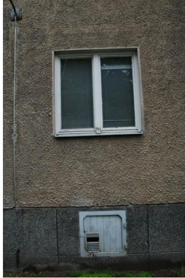
Ikkuna ja tarkastusluukku
