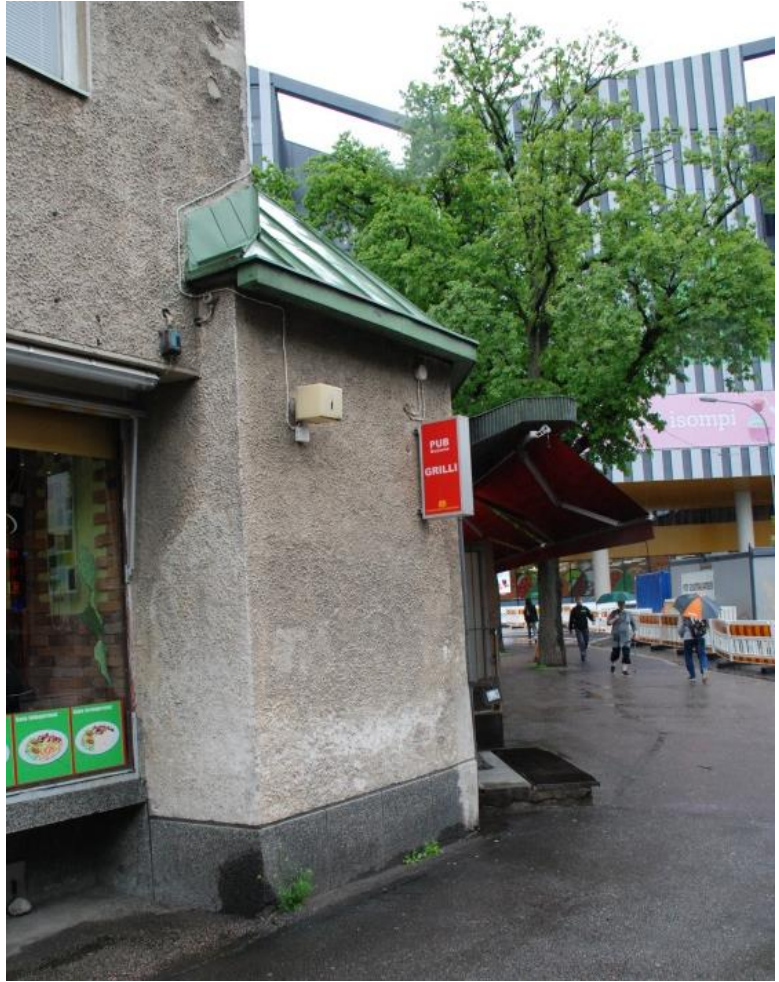
Kassatalon kattokulman detalji
