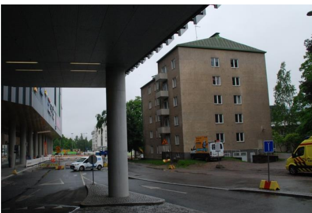
Dixin puoleinen julkisivu + pääty
