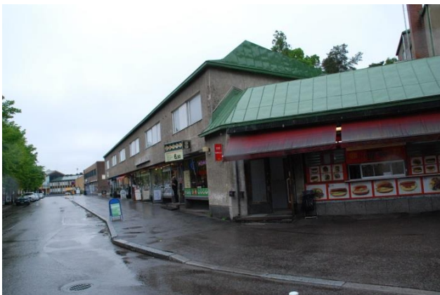
Asematien puoleinen julkisivu
