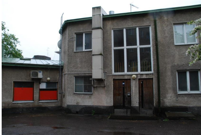
Liikerakennuksen sisäänkäynti sisäpihan puolelta
