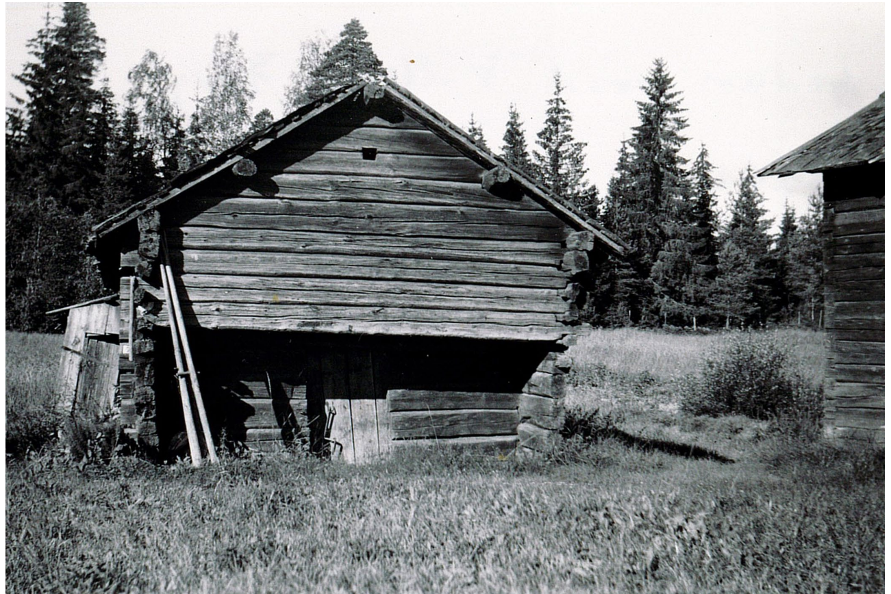
Aittarakennus Villen torpan pihapiirissä vuonna 1951, lähellä Bykullaa. KHF.
