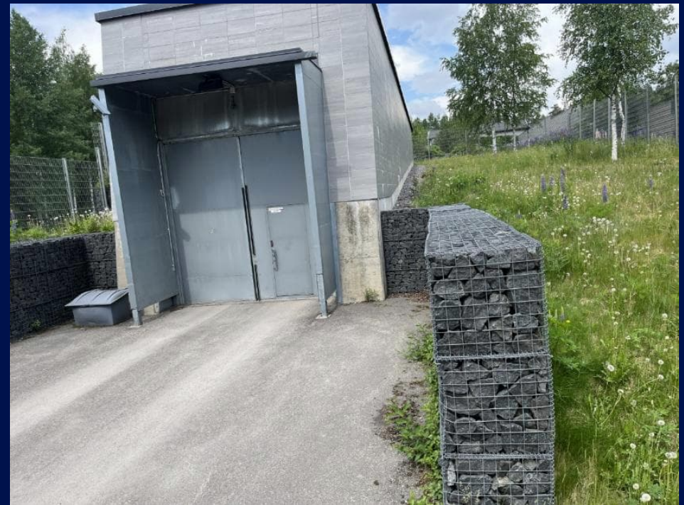
Esimerkki ajotunnelin rakennuksesta
