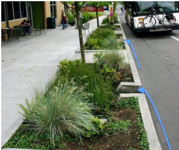
Hulevesiä keräävä katuviheralue. https://www.harvestingrainwater.com/gallery/street-side-water-harvesting-image-gallery/
