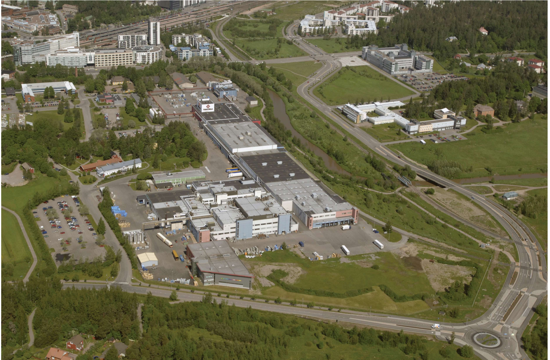
Ylläolevassa viistokuvassa vuodelta 2004 tehdasalue on jo siirtynyt nykyiselle paikalleen ja alue on lähes nykyisessä laajuudessaan. Vanha Ykköstehdas ja muut rakennukset on purettu ja niiden alue odottaa uutta rakentamista. Kartta Vantaan karttapalvelu. Ilmakuva tehdasalueesta v.2007Tikkurila Oyj.
