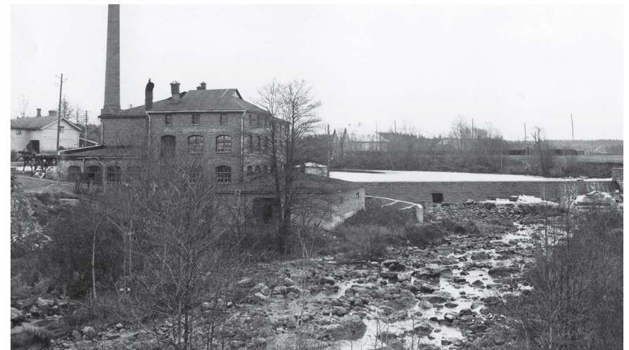
Keravan joen pato ja vernisstehtas 1930-luvulta. Kuva Mauno Mannelin, Vantaan kaupungin museo.
